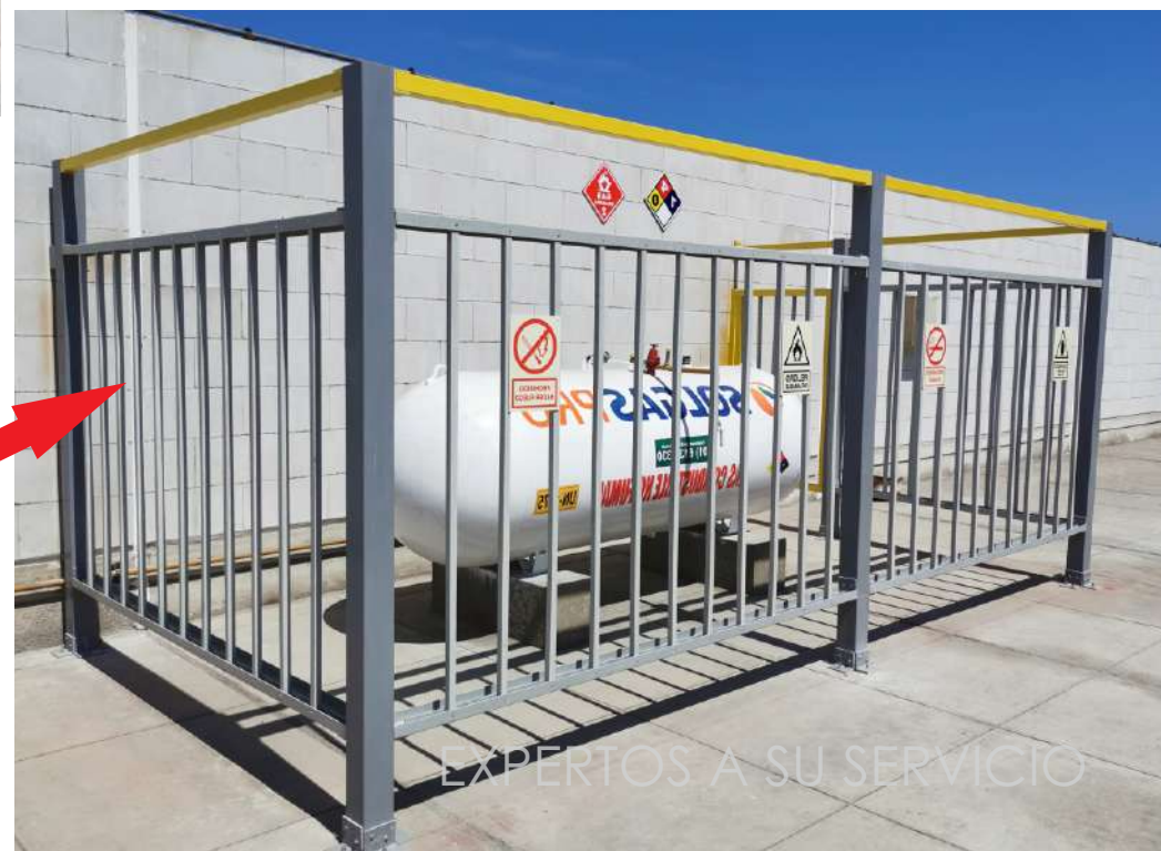
Cercos totalmente en fibra de vidrio (máxima duración contra la corrosión)
