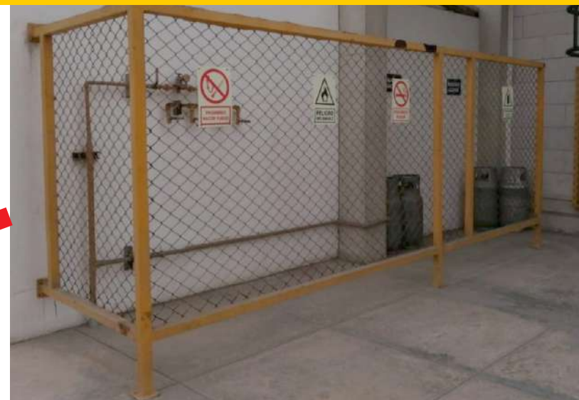
Cercos totalmente en fibra de vidrio (máxima duración contra la corrosión)
